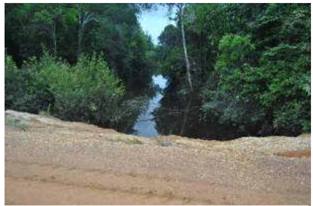
Badan jalan PT. Finnantara yang menutup badan sungai di Tembawang Alak
